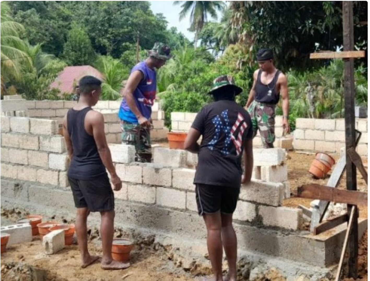
Satgas TMMD Ke-122 Kodim 1429/Butur Terus Dikebut Rehab RTLH
